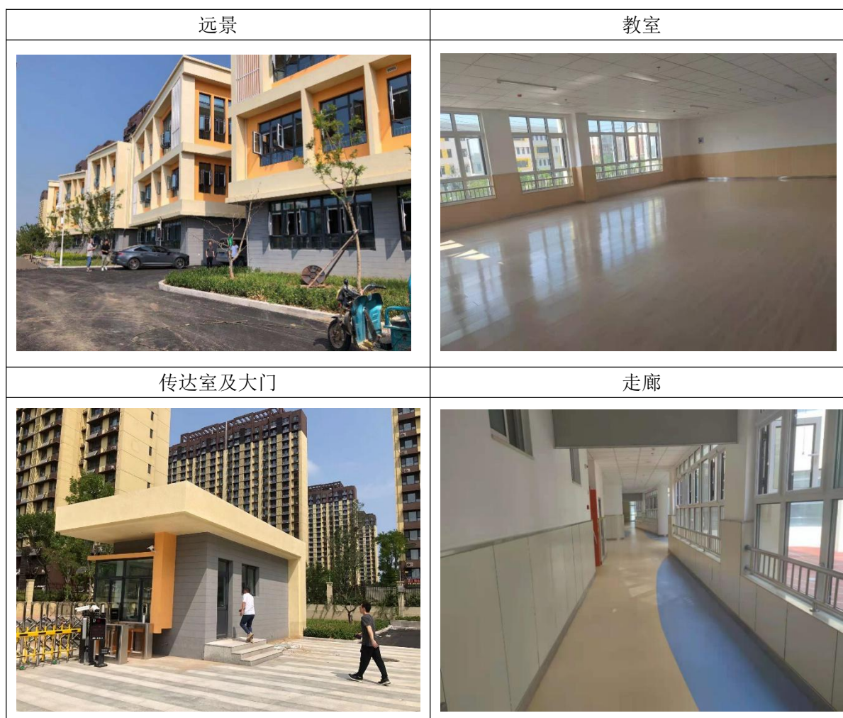
图 5 幼儿园现场建设情况
